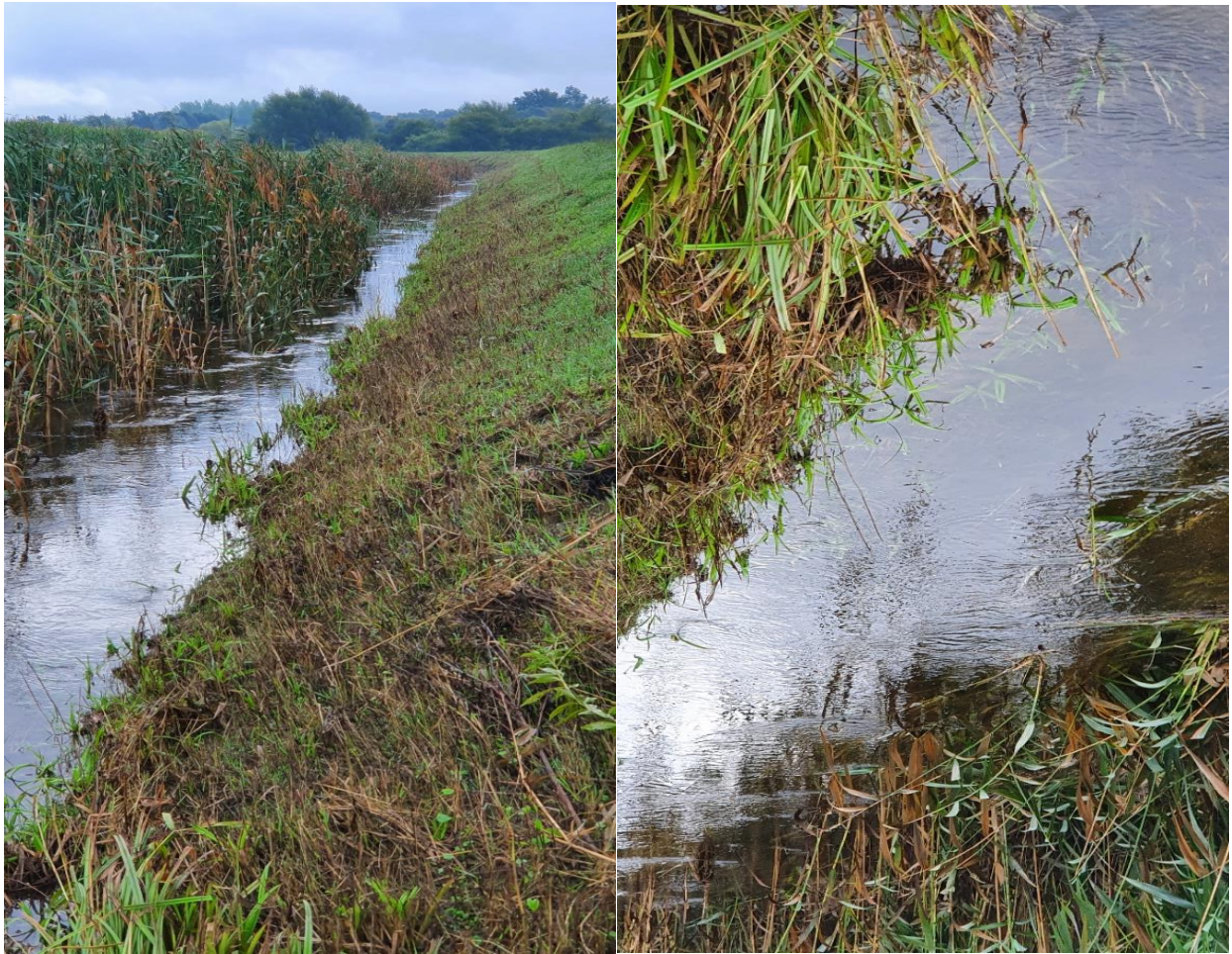
Potok Gliboki prema mostu Đelekovec i stanje vode na ispustu u Gliboki
