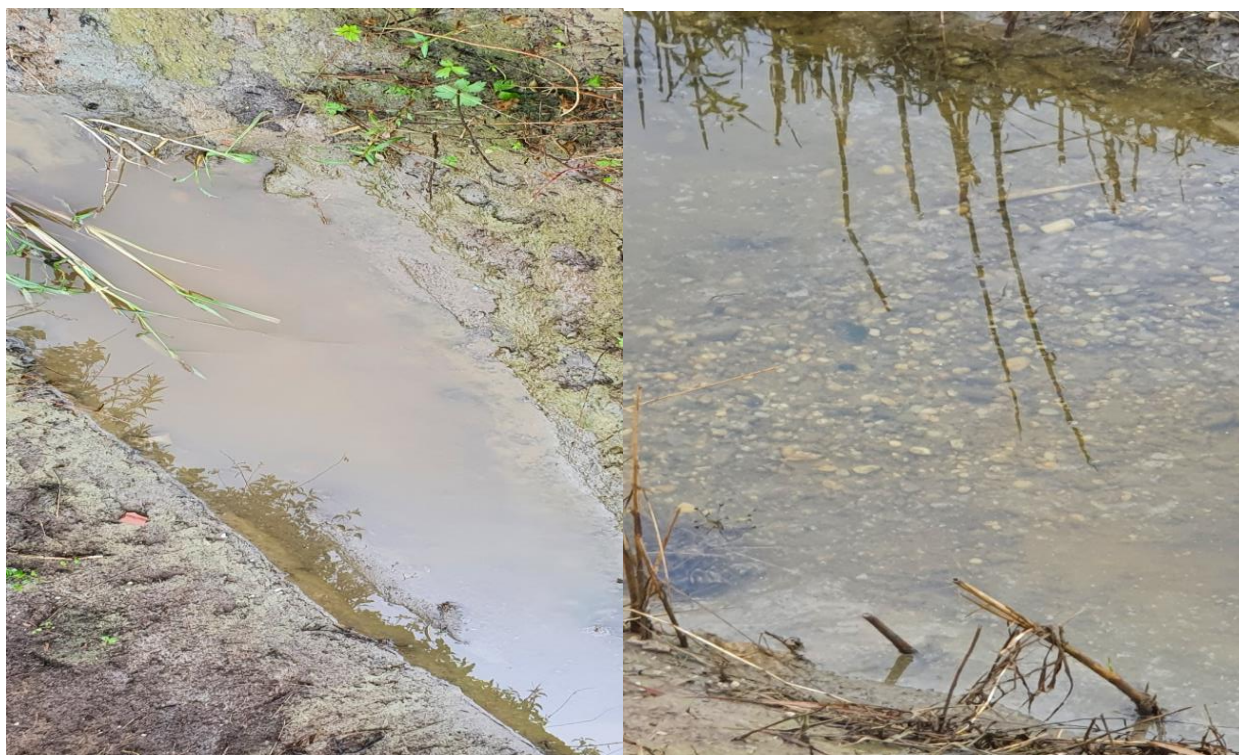
Stanje odvodnog kanala 04.08.2020.
